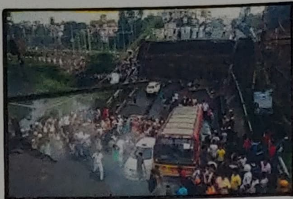
Pic.- Majherhat Bridge
